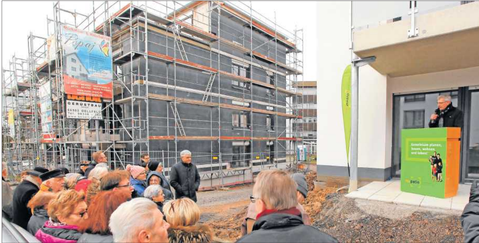
Im Patio-Quartier wurde gestern Richtfest für das zweite Stadthaus auf der Diakonieseite gefeiert. (Fotos: Scharf)
